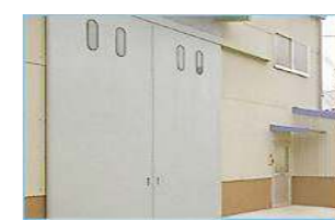
改造(アングル扉→軽量扉)
