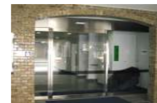
改造(フロアヒンジ→自動扉)
